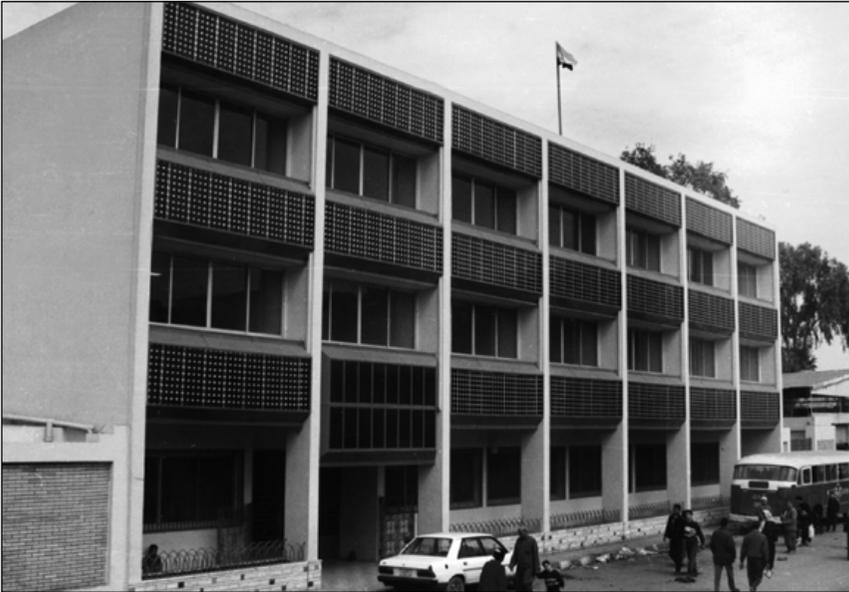
**Abbildung 3:** Photovoltaik-Fassade in Kairo mit einer installierten Leistung von 10 kWp
