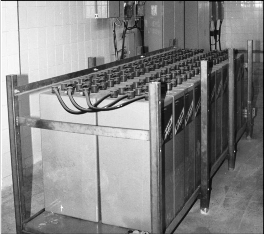
**Abbildung 4:** Batteriebank (2.300 Ah / 48 V) und elektrische Installation
