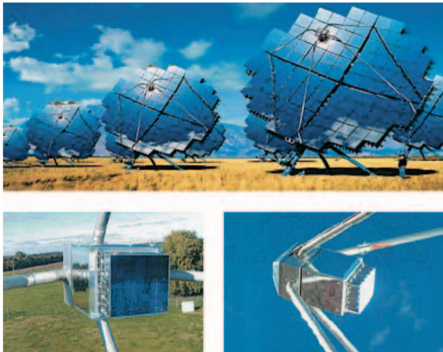
Abbildung 3 Zweiachsig nachgeführtes Dish-Spiegelfeldsystem des australischen Herstellers Solar Systems
